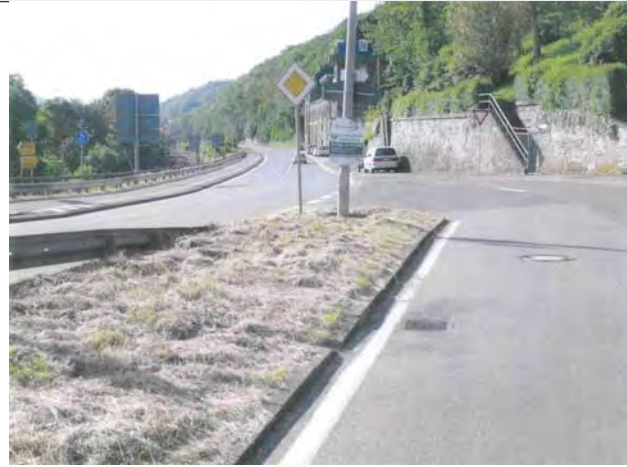
Ansicht Knotenpunkt Bestand - Blick Richtung Bingen
