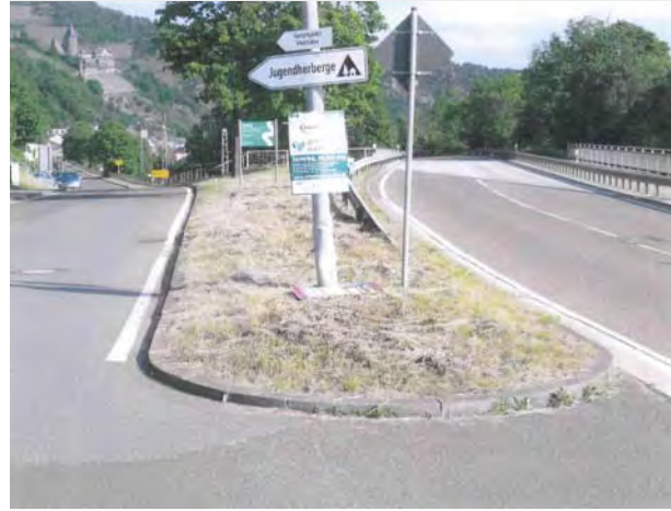
Ansicht Knotenpunkt Bestand - Blick Richtung Bacharach
