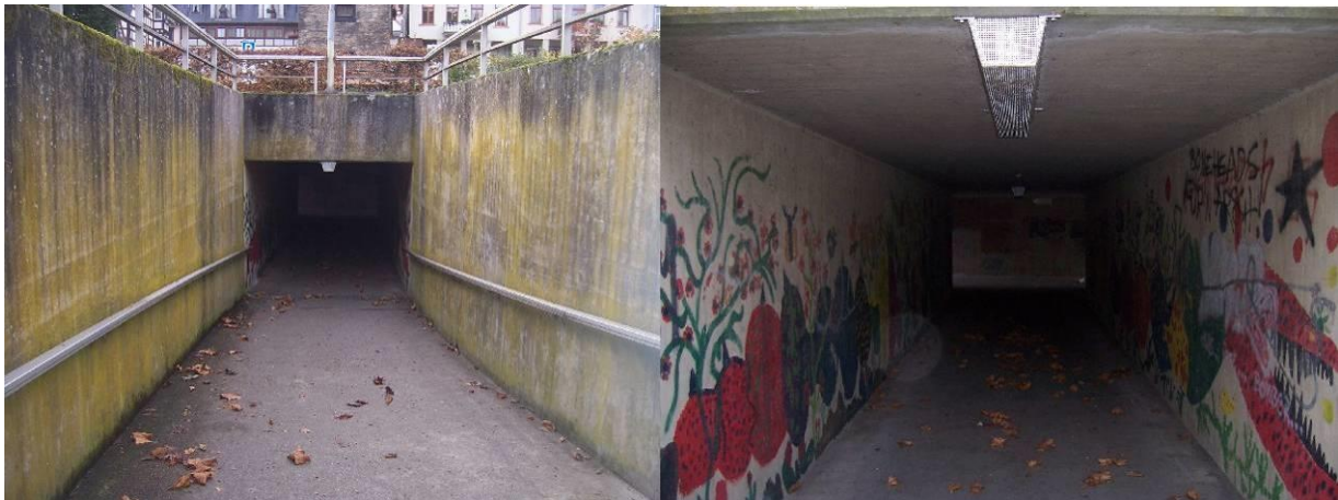
Abbildung 36: Unterführung an der B 9 (eigene Aufnahmen)
