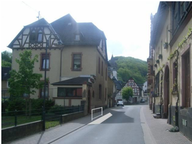
Abbildung 62: Errichtung eines Sperrbügels am vorhandenen Ein- und Ausgang (Variante 1)
