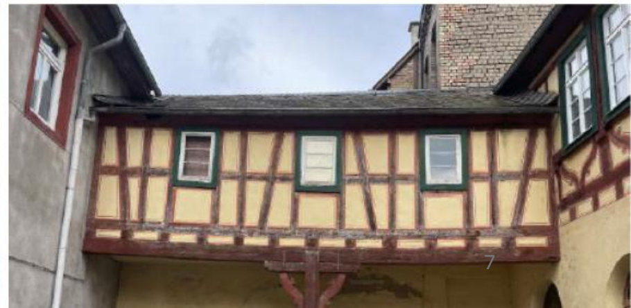
z.T. einfachverglaste Fenster
